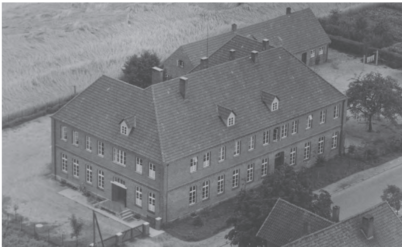
Die erweiterte neue Schule
