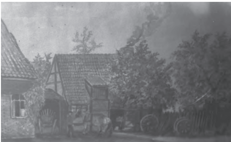
Die alte Schmiede Barg, Hauptstr. 29
